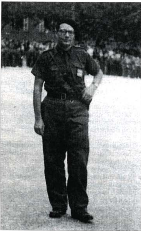
Fin août 1944 - avant l'inspection - Place du Champ de Foire à Limoges. (Photo Bernard Kofyan)
